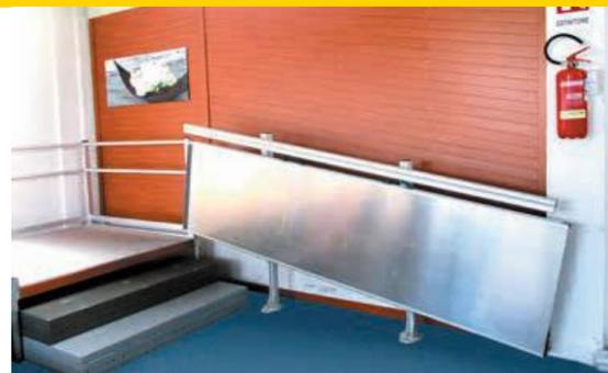
Struttura autoportante formata da due montanti verticali da fissare a terra e un corrimano in alluminio satinato.
